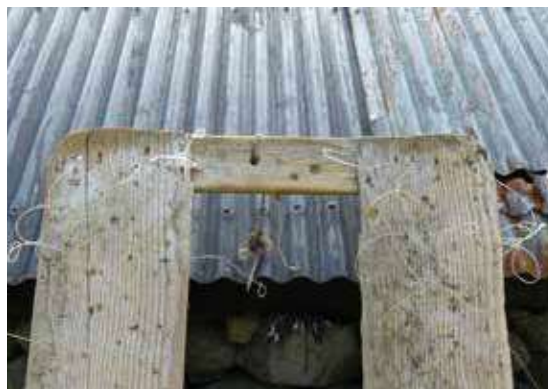
Foto 2. Hul til lokkefugl og hul til fortøjning.
