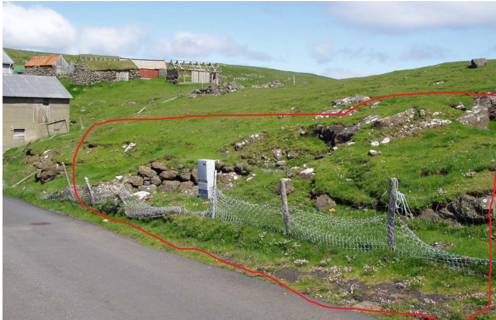
Mynd 6: Malarendavegurin oman á havnaekið. Omanfyri vegin físis luft og vatn út á vegin, tá nógv brim er eystanfyri
